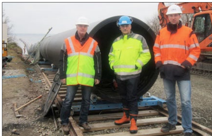
Christer Johansson och Lars-Anders Fridström från Sydsvatten inspekterar intagsledningen tillsammans med Roger Svensson BCA. Bilden togs strax innan stormen.
